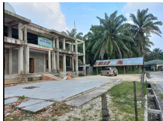
Kondisi eksisting masjid dilihat dari arah Selatan, dimana terlihat struktur bangunan yang belum dilapis dengan kulit bangunanannya
