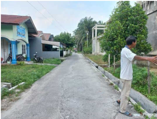
Kondisi exsisting jalan disamping masjid
