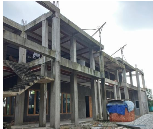
Kondisi exsisting masjid dilihat dari belakang
