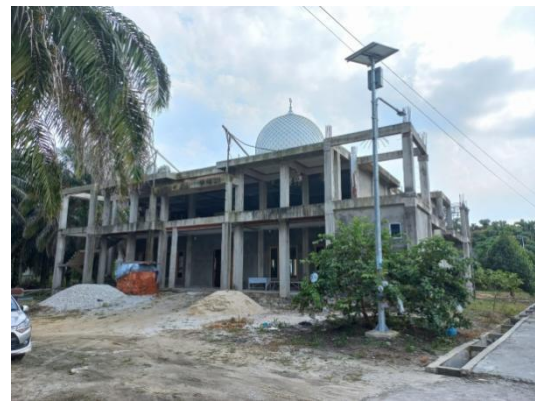
Kondisi Existing masjid dilihat dari arah selatan
