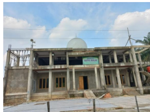
Kondisi existing masjid dilihat dari depan
