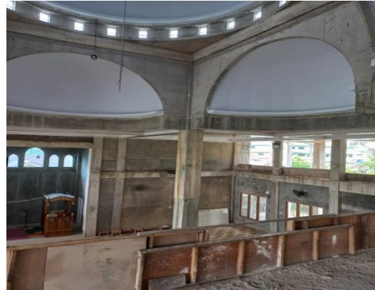
Kondisi Existing interior masjid
