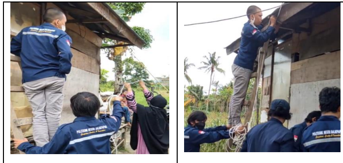
Gambar 6. Penarikan kabel dari panel utama ke tiang-tiang PJU dan pemasangan lampu DC 3 watt
