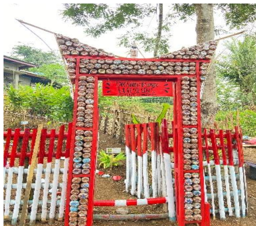
Gambar 4. Gapura taman yang telah rampung dibangun menggunakan ecobrick
